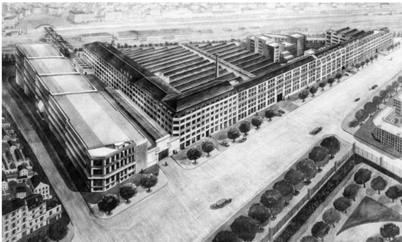
Usine du boulevard Kellermann DR© copyright Safran
