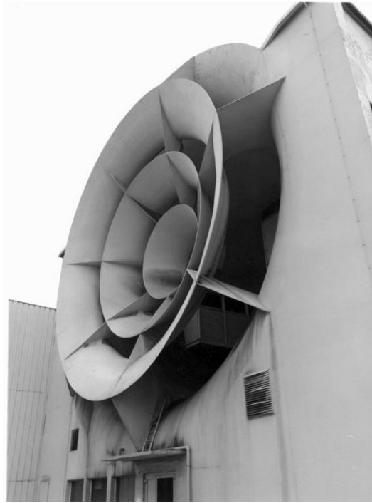
Entrée d'air de la soufflerie de l'usine H-S de Bois-Colombes (Copyright Espace Patrimoine Safran)
