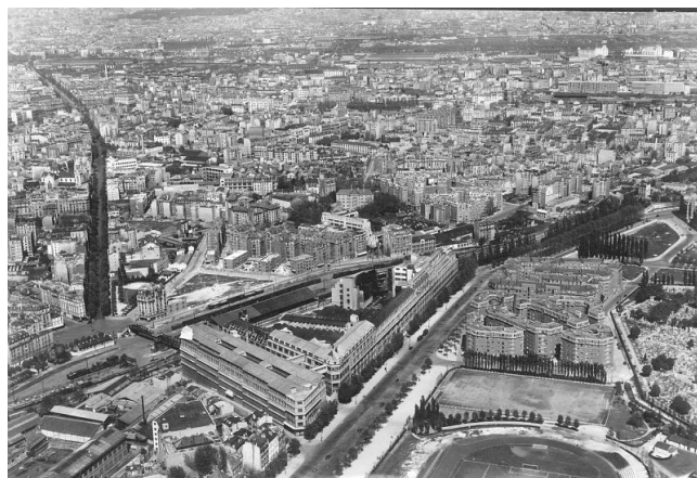
Vue aérienne du site (Copyright EspacePatrimoine@Safran)
